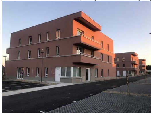
La première tranche de la résidence Tempo comprend quatre bâtiments, à Acigné. | OUEST-France
